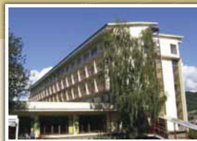
Domov důchodců Bystřany, příspěvková organizace Pražská ul. 236 417 16 Bystřany
